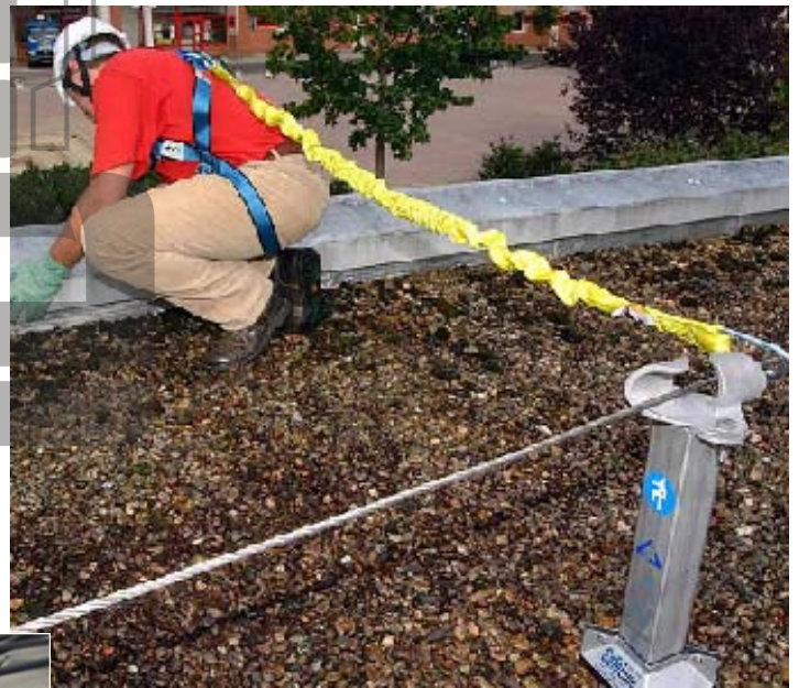
شکل ۵۴-۲- محدود کننده با اتصال یک طناب
