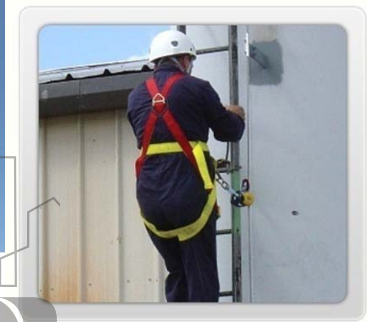
شکل ۷۴- صعود از نردبان با ابزار متوقف کننده
