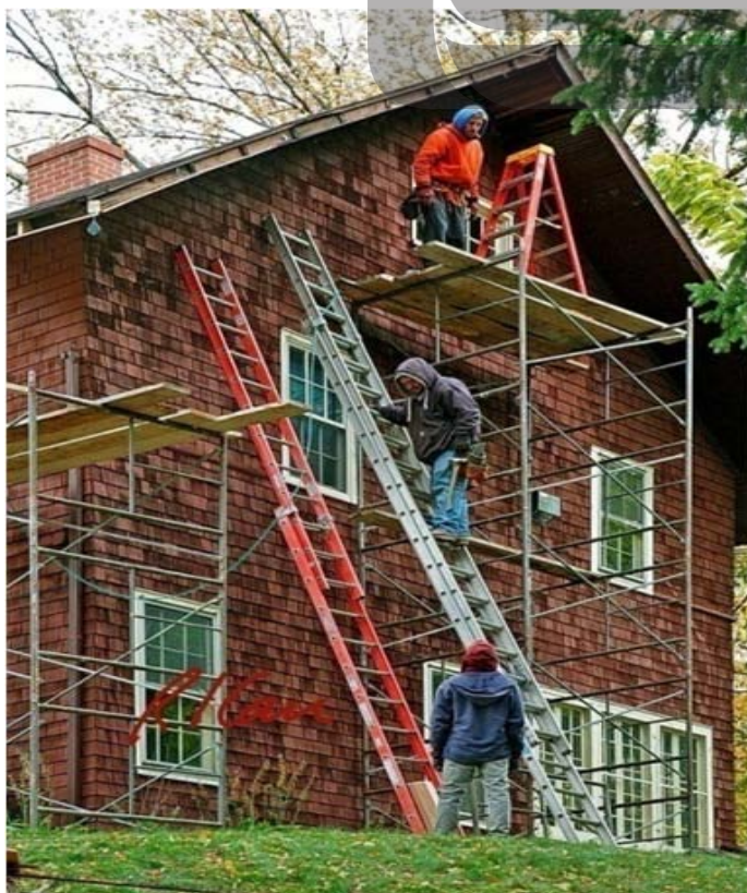
شکل ۲۷- تکیه استقرار نردبان در شیب زمین
