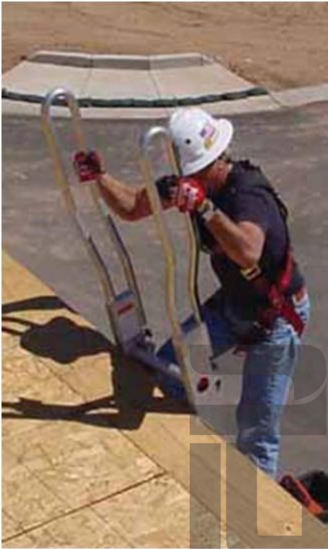
شکل ۶-۱ دستگیره نردبان ثابت
