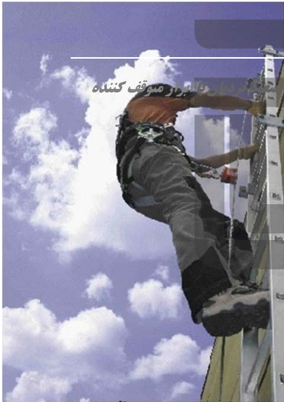
شکل ۷۶- صعود از نردبان با ابزار متوقف کننده
