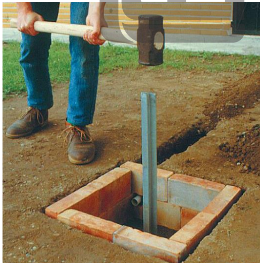
شکل (۳-۲): نمونه‌های دیگری از الکترودهای قائم، سمت راست: الکترود لوله‌ای، سمت چپ: یک نمونه الکترود پروفیلی
