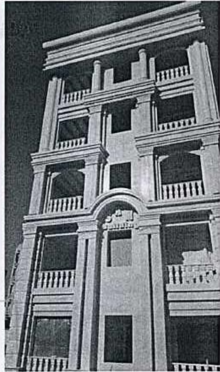
شکل ۱۶- نمای پروژه با احجام و پیش آمدگی بیش از حد مجاز و استفاده از صراحی و ایمن نبودن نرده سنگی از لحاظ ارتفاع و اتصال به سازه اصلی، که نیازمند اتخاذ تدابیر مناسب می باشد.
