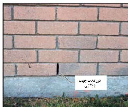
شکل ۵-۱۳- خالی گذاشتن درز ملات جهت زه‌کشی
