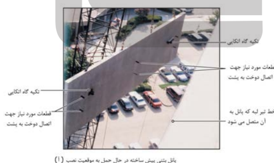
پانل بتنی پیش ساخته در حال حمل به موقعیت نصب (۱)
