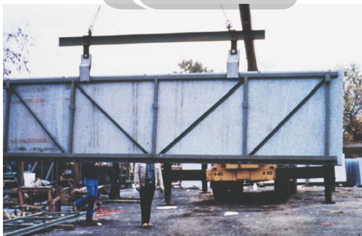
شکل ۴-۲۱- پانل دیواری پرده‌ای پیش ساخته سنگی
