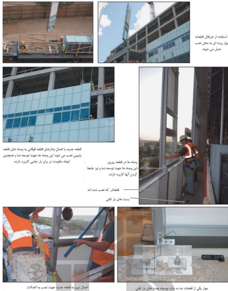
شکل ۹-۱۲- مراحل نصب نمای پرده‌ای یکپارچه
