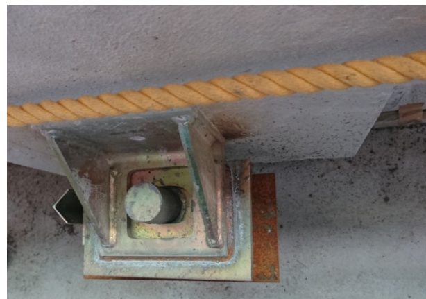
شکل ۱۰-۶- نمونه هایی از عناوین تکیه گاه اتکایی در پانل های بتنی پیش ساخته
