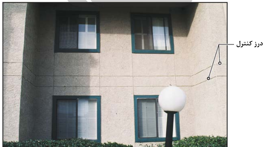
شکل ۶-۲- نمونه درزهای کنترل بر روی نمای سیمانی
