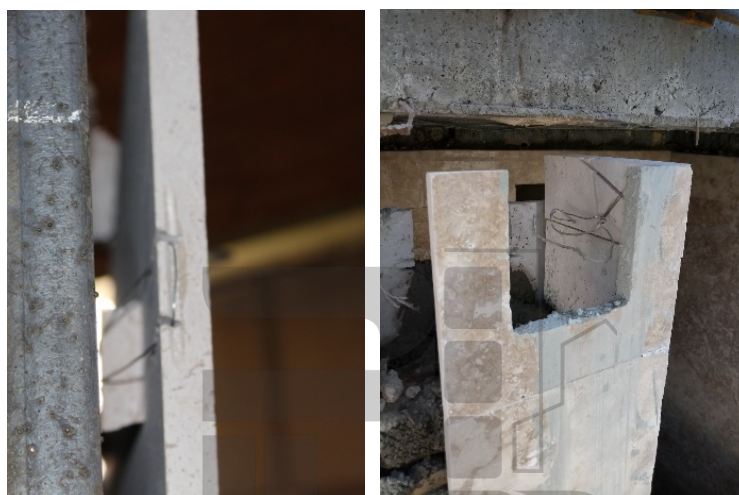
شکل ۲-۴- نمونه‌هایی از مه‌ارهای سیمی فولادی
