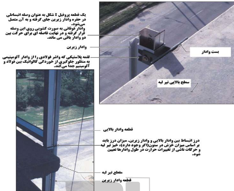
شکل ۹-۷- نمونه اتصال انبساطی بین دو قطعه وادار
